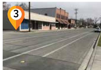
3 Rehabilitación del pavimento asfáltico de la calle 2nd Avenue Reemplazar la superficie del asfalto existente, correcciones a los servicios públicos y repintar las franjas de tráfico; de la calle Birch a la calle Howard
