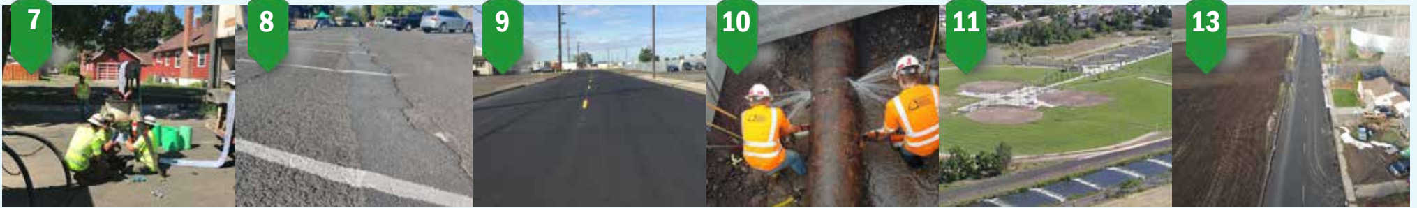
7 Revestimiento del alcantarillado principal De la escuela Garrison a la calle Poplar Street • Verano-Otoño de 2022
