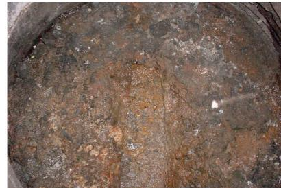
**Un vistazo a la boca de alcantarilla de un desagüe y una capa sólida de sedimentos o materia residual de FOG.**
